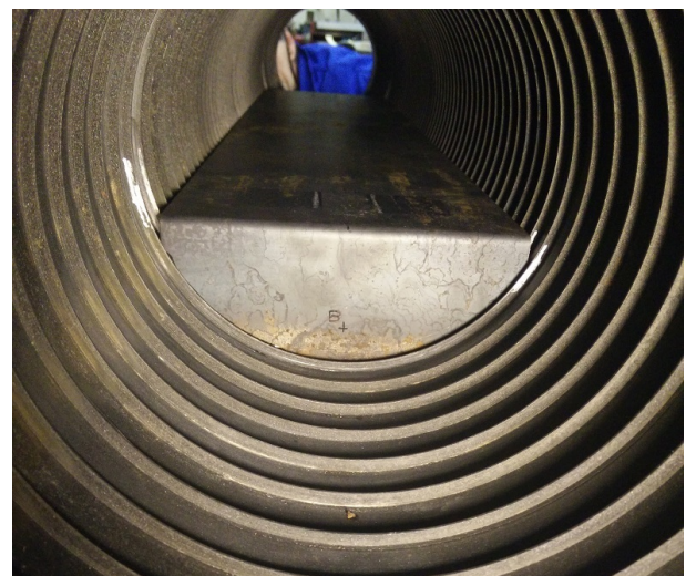
FIGURE 4 – Cylindre raidi vu de l'intérieur avec structure interne non-axisymétrique.
